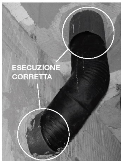
Particolare attraversamento muratura
